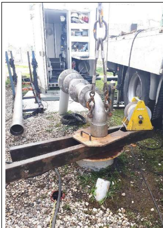
Forage de Lagravette à Lafitte sur Lot
